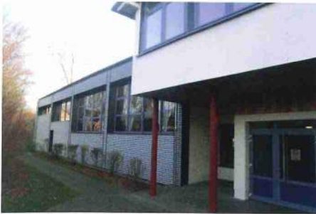
Seitenansicht der Halle nach der energetischen Sanierung
